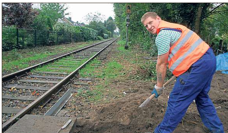
Bei der Arbeit: Andrzej Przeslak von der Firma Eggebusch erneuert an der Lütgenbreite den Bahnübergang. Bild: Aundrup
